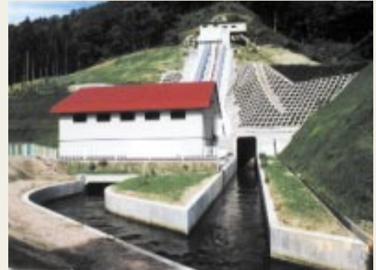
大森前水力発電所 当社は十和田湖の外輪山に発する大湯川水系に、6つの発電所をもっている。
