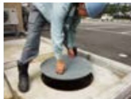
マンホール軽量化によるリスク低減と作業時間の短縮
