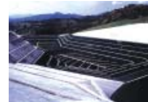
グリーンフィル小坂（最終処分場）
