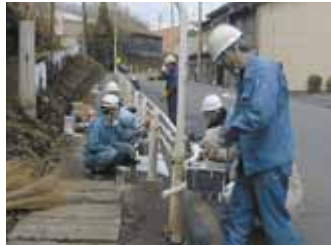
小坂製錬 ガードレール塗装
