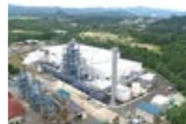
低濃度PCB廃棄物無害化処理施設(エコシステム秋田)
