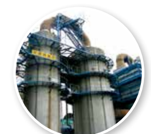
フロン破壊処理を行うエコシステム秋田
