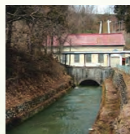
大湯第四発電所
