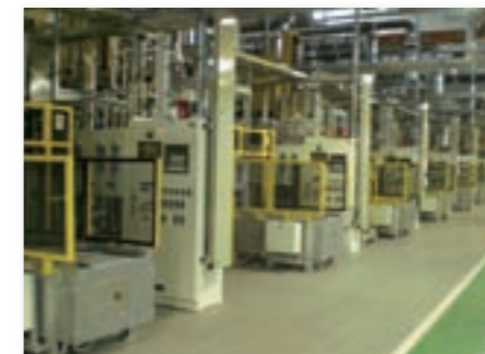
高効率熱処理設備(浸炭炉)
