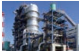
完成した焼却炉
