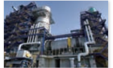
エコシステム千葉 新焼却炉
